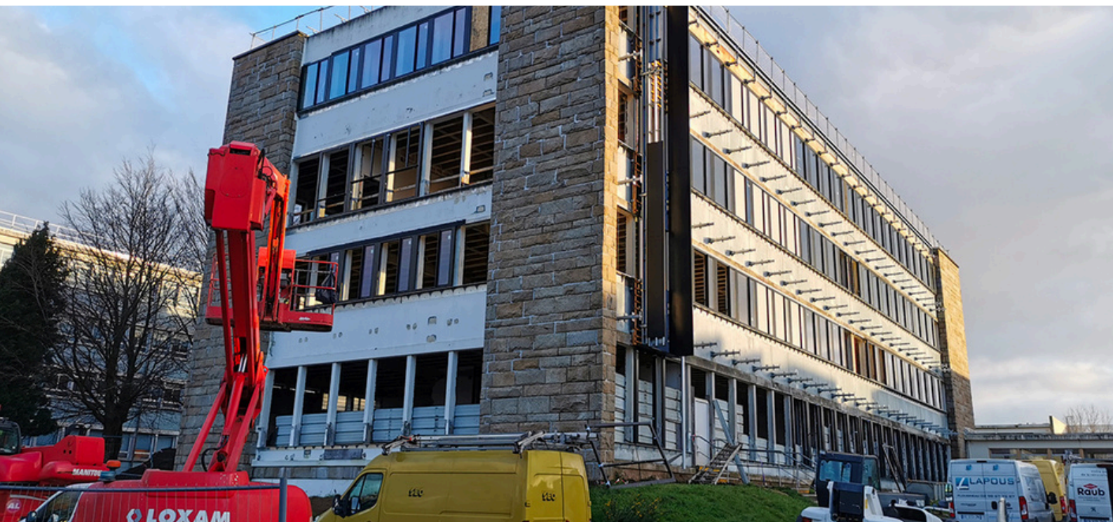
Le bâtiment G de la faculté des Sciences et Techniques bénéficie d'un ambitieux programme de rénovation énergétique.
