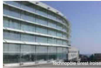
Technopôle Brest Iroise
